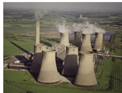
電力プラント・ボイラー
