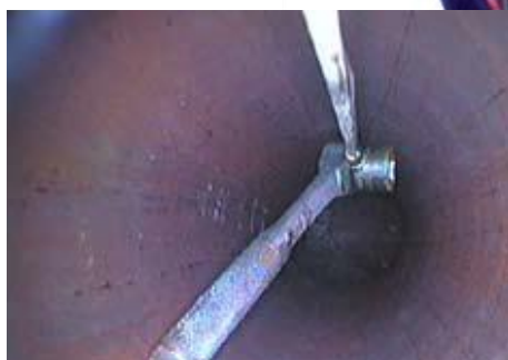
Turbina de Gás
