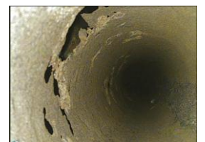
Aquecedor da Alimentação de Água
