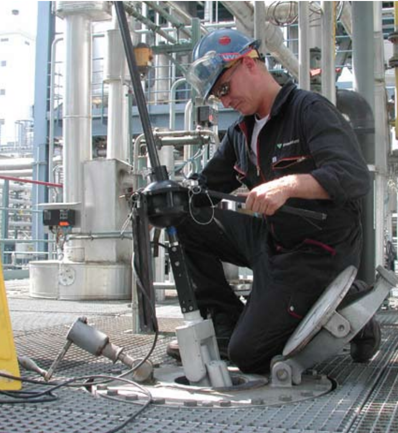
Contrôle d'un réservoir d'usine chimique avec le système PTZ140 équipé de tige télescopique et du trépied à bille.
