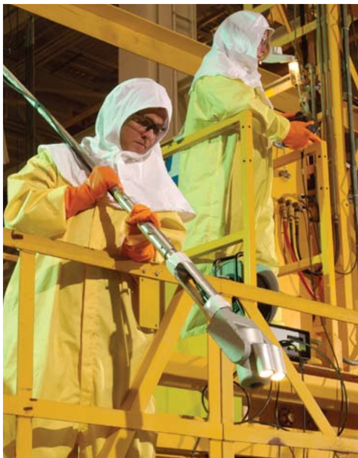
Opérateurs effectuant des contrôles visuels de la cuve d'un réacteur nucléaire avec le système de contrôle numérique Ca-Zoom PTZ
