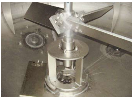
Lame détachée dans une cuve d'agitation à cause de boulons cassés
