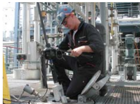
Contrôle de cuves et de réservoirs
